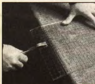
A letört drótüveg a vékony drótvégeken gyakran egyben marad. Ha egyenes élre van szükségünk, akkor a drótdarabokat el kell távolítani
