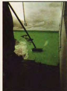
Esztétikai betonpadlóburkolat készítése REOKORR N padlóbevonó anyagból.
